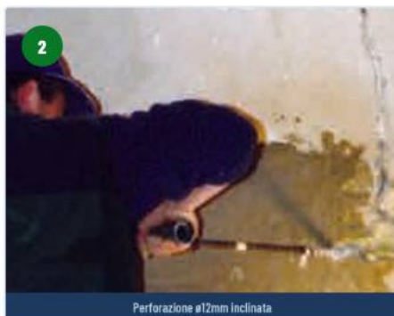
Perforazione ø12mm inclinata
