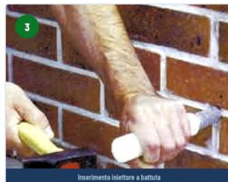
Inserimento iniettore a battuta
