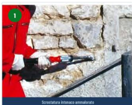
Scrostatura intonaco ammalorato
