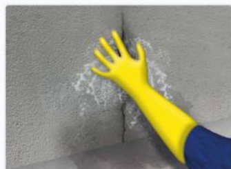
ARRESTO DI INFILTRAZIONE ATTIVA
