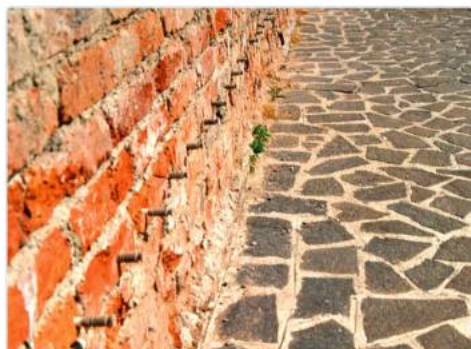
Iniettori installati su parete in mattoni a contatto con il terreno
