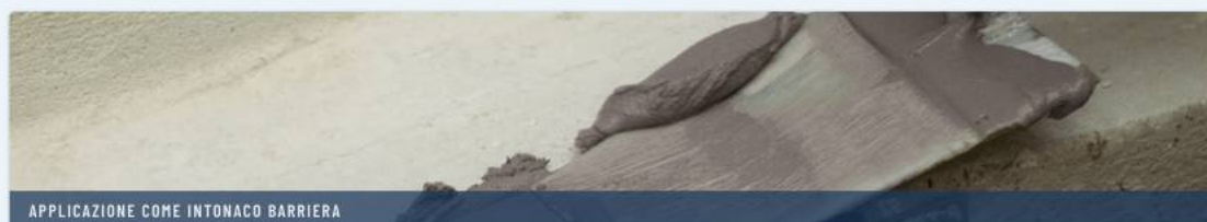
APPLICAZIONE COME INTONACO BARRIERA
